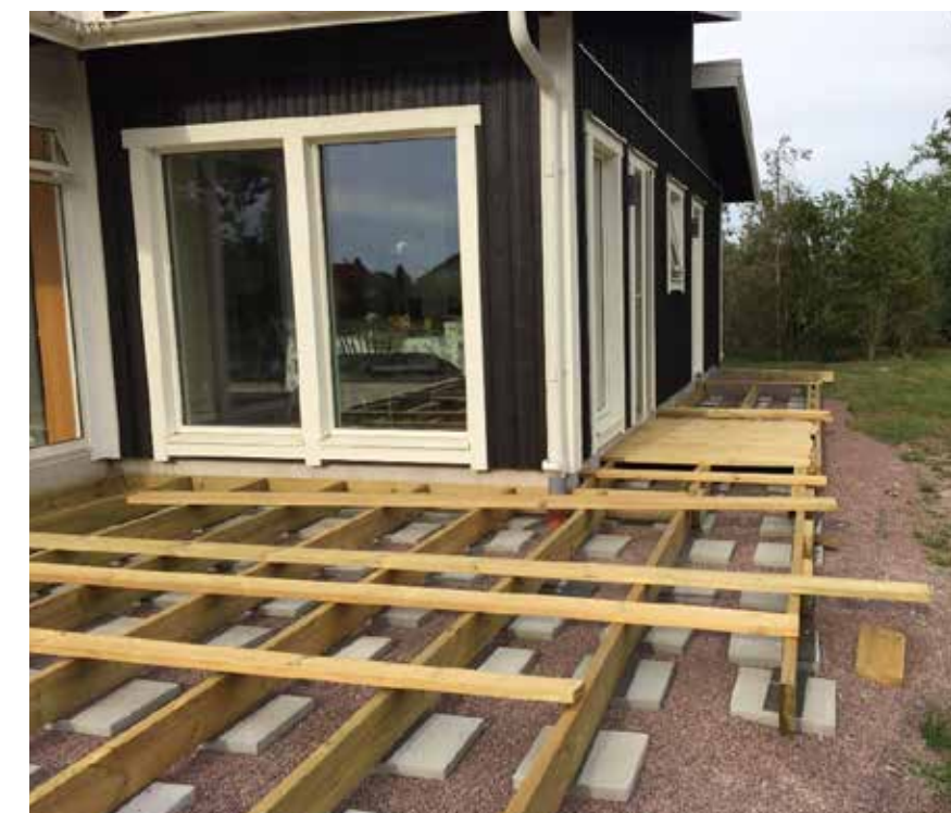
Vid altanbygge är det viktigt för bästa resultat att grundläggningsarbetet görs noggrant.
